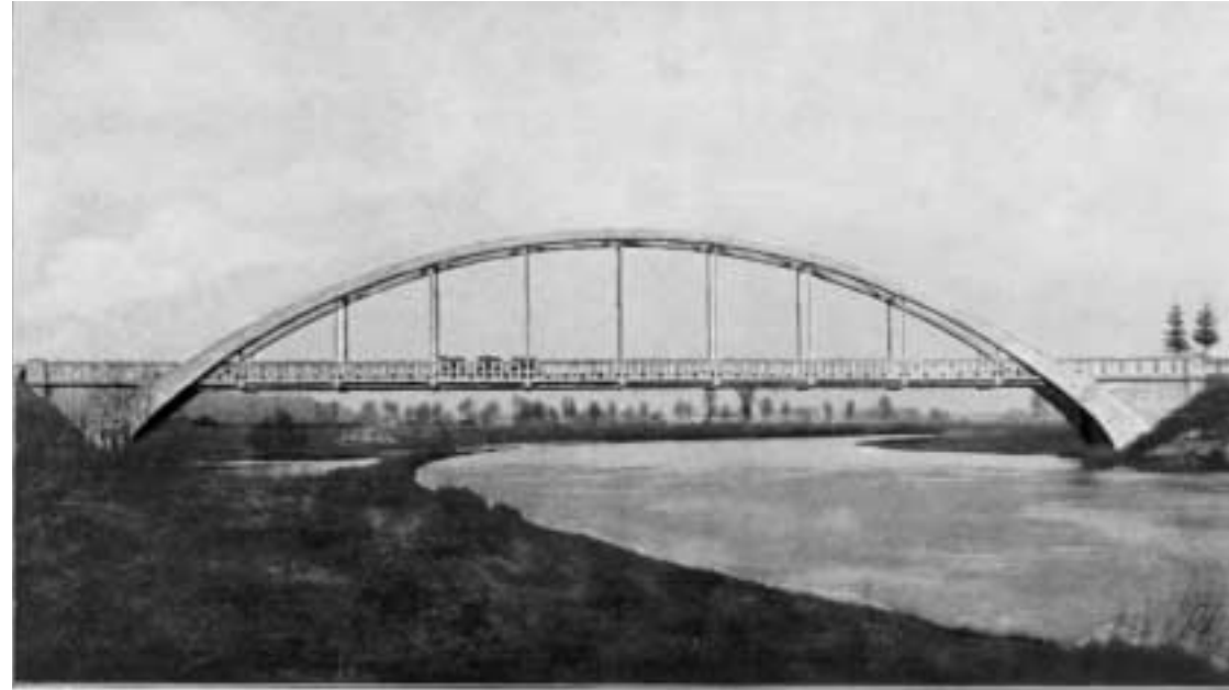
Unterleiterbach a. M. Eisenbeton-Brücke ü. d. Main, 53 m Spannweite, nach System Dr. v. Emperger Erbaut 1913/14. Thüringer Betonbaugesellschaft Otto Hauch & Co., Coburg
