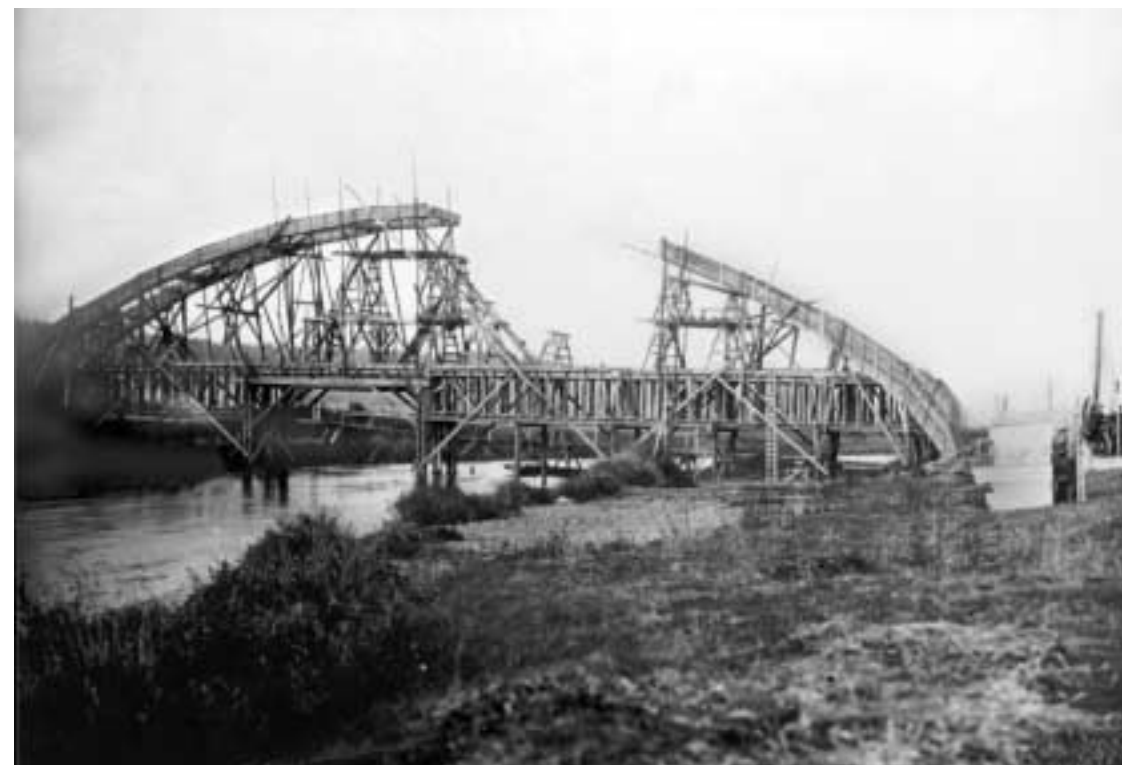
Die Unterleiterbacher Mainbrücke während der Errichtung des Lehrgerüsts (Herbst 1913). Hinter der Brücke der Notsteg aus Holz sowie die Fähre. Rechts im Bild die Dampfmaschine zur Energieerzeugung (Foto J. Hospe, Staffelstein, Besitz Klaus Beyersdorf, Fa. O. Hauch, Coburg)
