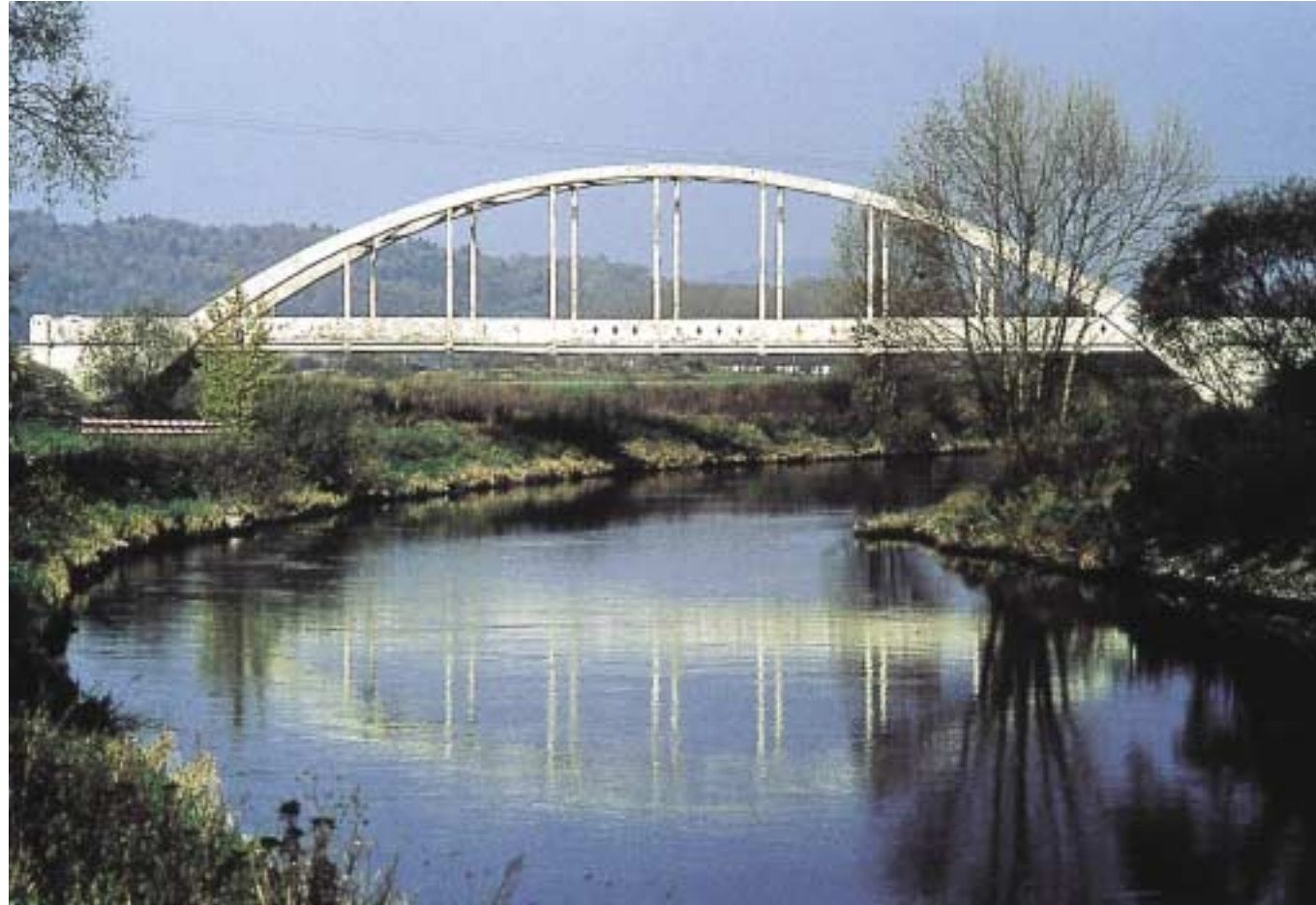
Die Unterleiterbacher Mainbrücke von Zapfendorf aus gesehen (Foto: Hans-Jürgen Köstner, Altenkunstadt)
